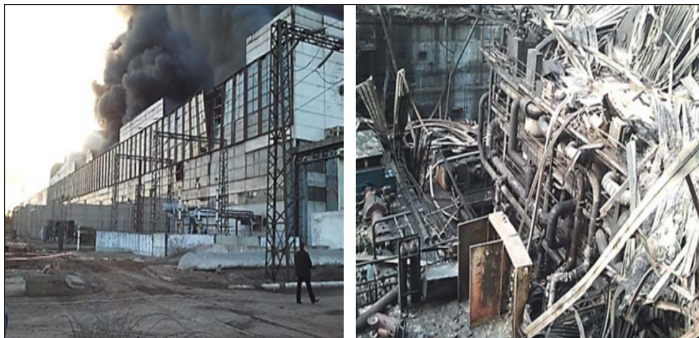
Рис. 1. Пожежа, яка сталася у 2013 році на Вуглегірській ТЕС та зовнішній вигляд зруйнованого пожежою машинного залу
